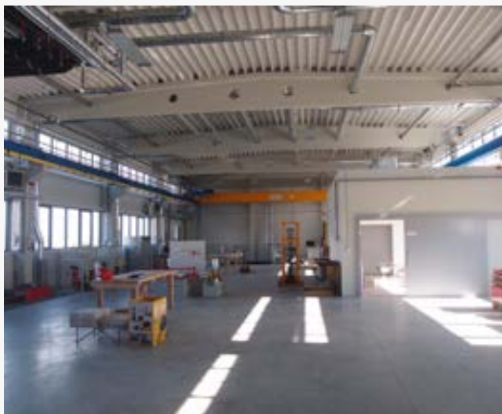
Centrum AdMaS - hala P2
